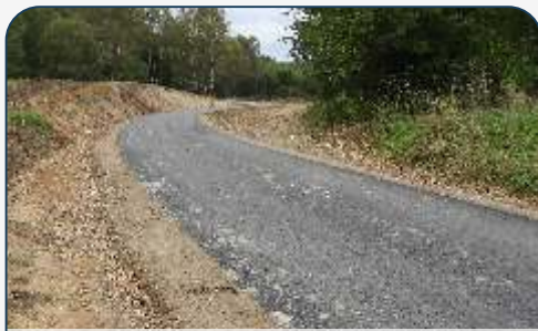
Przebudowa drogi w Modrzejewie
