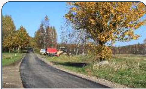
Nowa nawierzchnia w kierunku Masłowiczek
