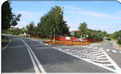
Przebudowa skrzyżowania i ul. Ogrodowej
