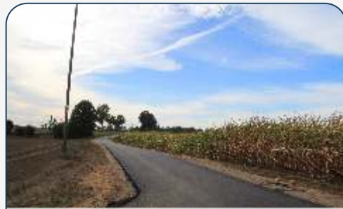
Nawierzchnia asfaltowa w Ciemnie
