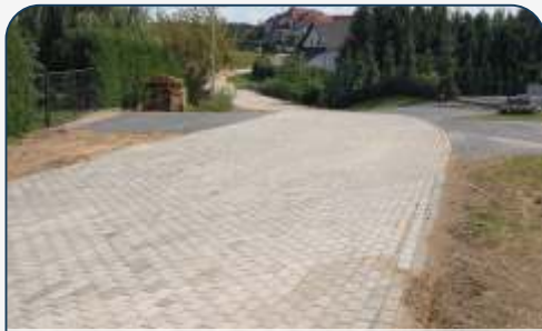
Nawierzchnia z kostki na ul. Słowackiego
