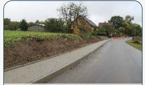
Przebudowa drogi w Trzebiatkowej
