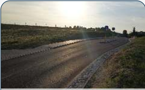
Przebudowa drogi w Ciemnie
