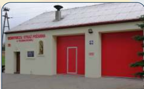
Termomodernizacja remizy w Trzebiatkowej
