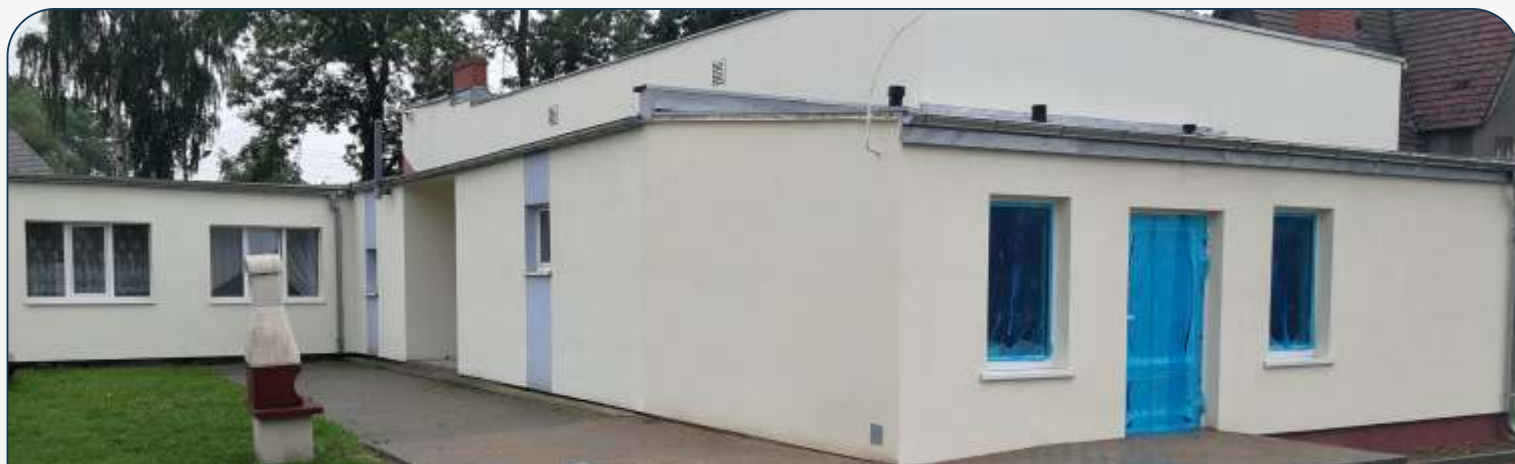
Budowa węzła sanitarnego przy WOK w Trzebiatkowej
