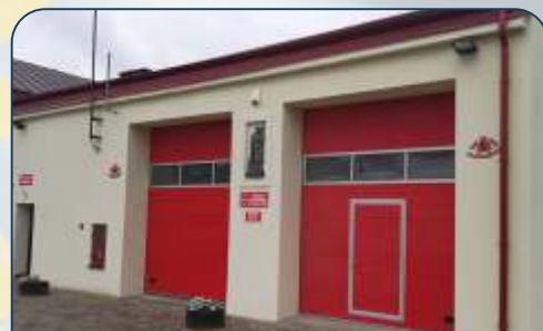
Termomodernizacja remizy w Kramarzynach
