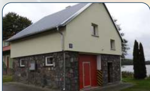
Termomodernizacja remizy w Piasznie
