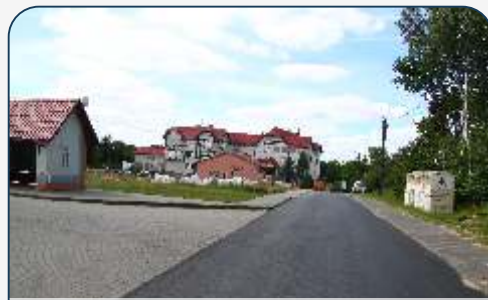
Przebudowa ul. Sportowej w Tuchomiu
