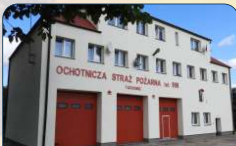
Termomodernizacja remizy w Tuchomiu
