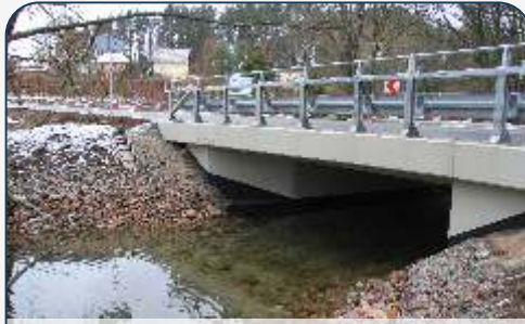
Przebudowa mostu w Ciemnie
