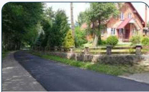
Nowa nawierzchnia w Piasznie
