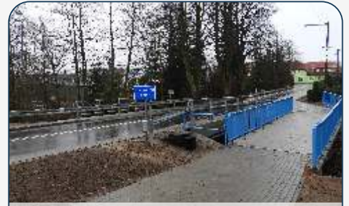
Przebudowa drogi i mostu na ul. Lipowej
