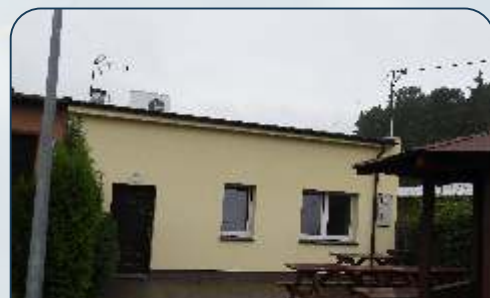
Termomodernizacja świetlicy w Masłowicach Trzeb.
