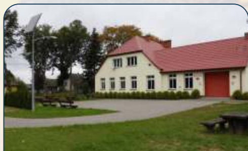
Termomodernizacja świetlicy w Modrzejwie
