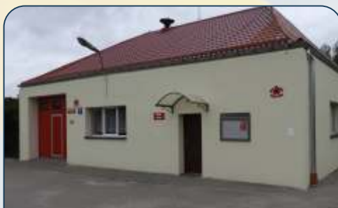
Termomodernizacja remizy w Tągowiu
