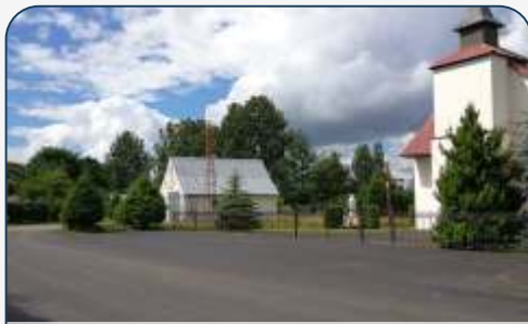
Nawierzchnia asfaltowa w Modrzejewie
