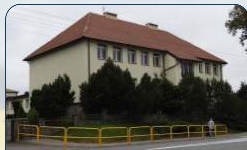
Termomodernizacja szkoły w Kramarzynach
