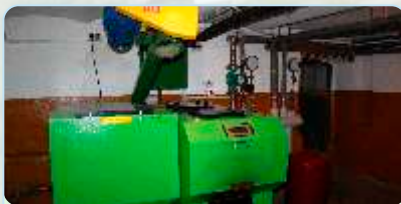
Modernizacja kotłowni i instalacja solarów w CMS w Tuchomiu
