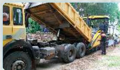
Droga betonowa w Piasznie
