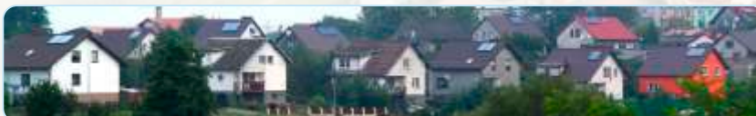
Montaż 266 solarów na budynkach mieszkalnych we współpracy ze Stowarzyszeniem Miłośnicy Gminy Tuchomie
