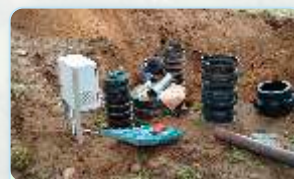
Wybudowano 57 przydomowych oczyszczalni ścieków
