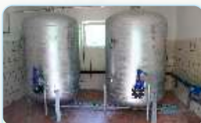
Zmodernizowano hydrofornie na terenie gminy
