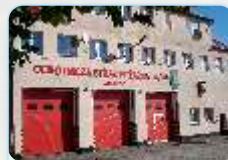
Modernizacja kotłowni na biomasę oraz zainstalowanie solarów w remizie OSP w Tuchomiu
