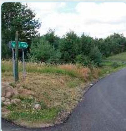
Ścieżka asfaltowa w Piasznie - 700 m
